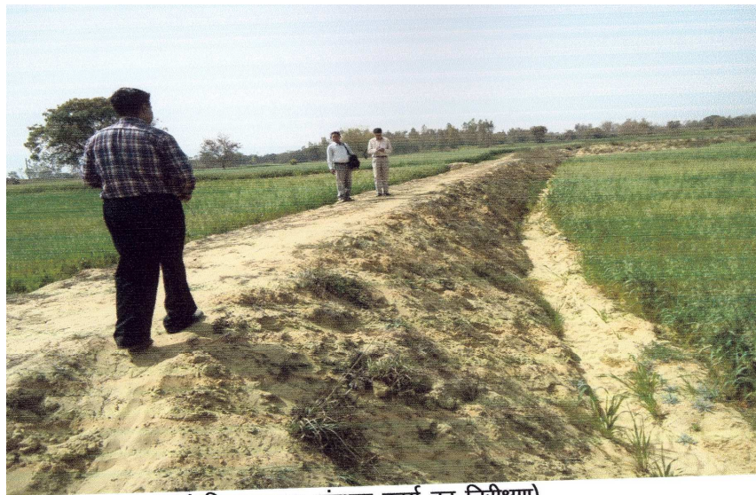
(भूमि एव जल संरक्षण कार्य का निरीक्षण)
