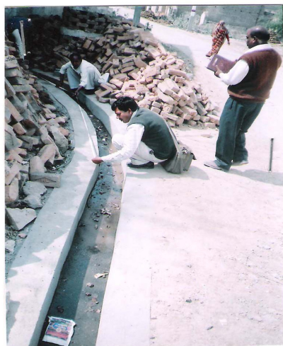
Naali maintenance at Maigaon
