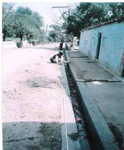
Naali maintenance at Maigaon
